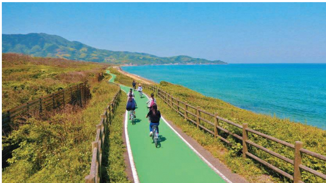
▲サイクリングロード「遠賀宗像自転車道」
