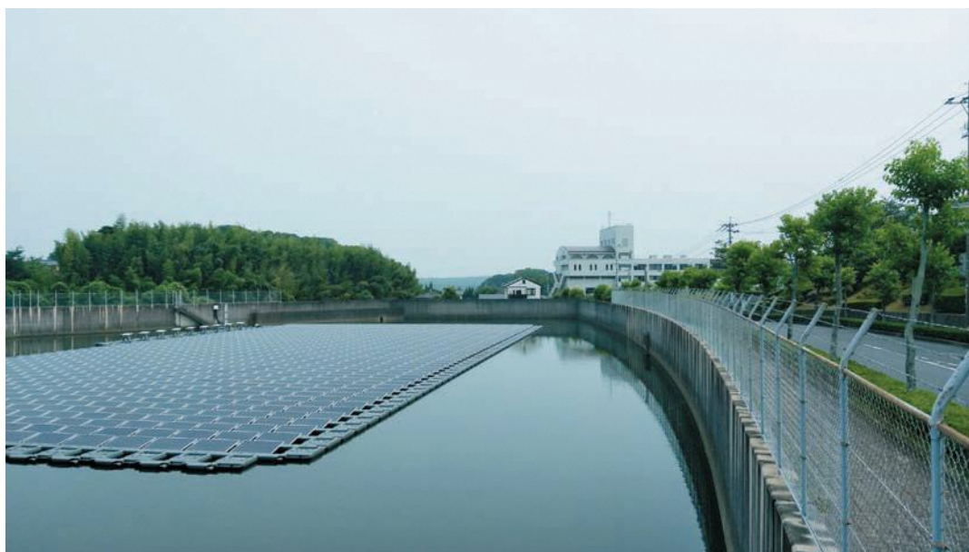
▲ため池水面を活用した太陽光発電
