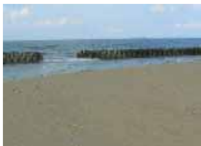
離岸堤群建設 昭和41年頃～
