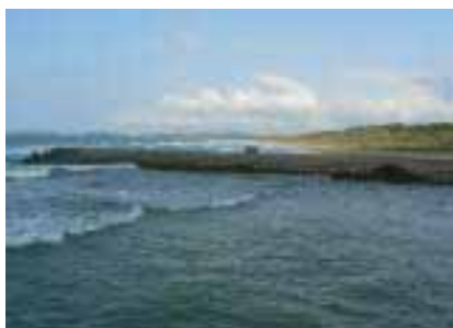
導流堤建設 平成41年頃～
