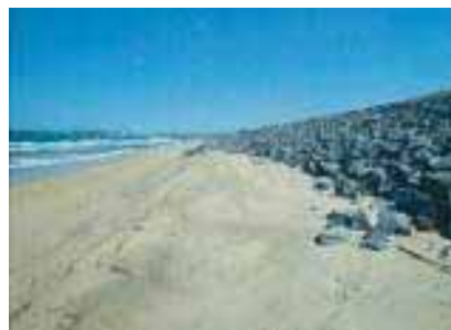
石積護岸建設 平成11年頃～
