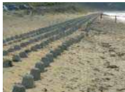
消波ブロック護岸建設 昭和58年頃～
