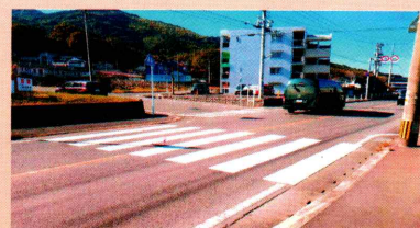
通学路の横断歩道白線の補修
