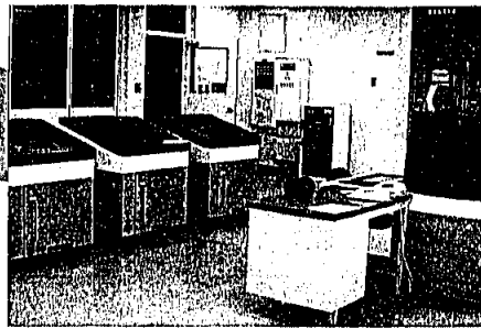
岡垣町浄化センター内の管理制御室
