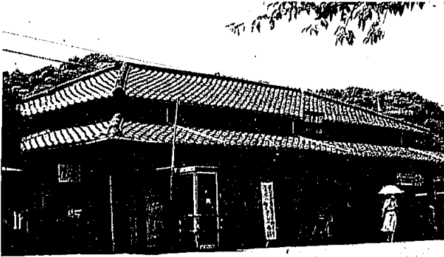
明治42年の建造物・旧海老津駅
