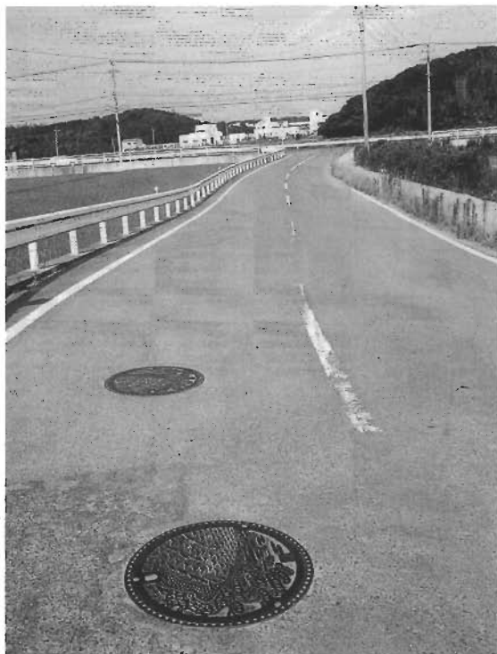
下水道のマンホールと岡垣町浄化センター
