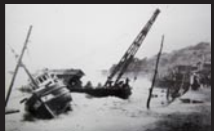
▲ 1955 (昭和 30) 年 9 月、波津防波堤工事中に台風襲来、船が県道下まで打ち上げられた
