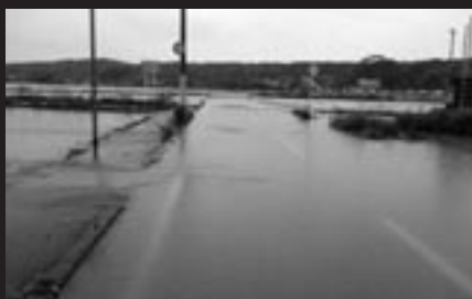
▲ 岡垣町浄水場～元松原交差点周辺の冠水
