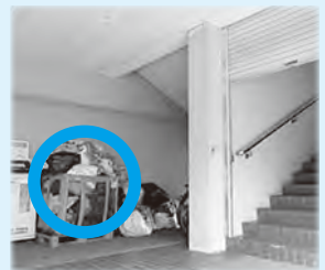
▲東部公民館(町民体育館に入ると階段付近)
