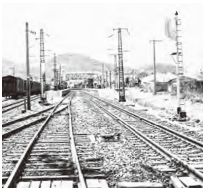
▲跨線橋があった頃の海老津駅構内
