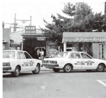
▲海老津駅仮駅舎
