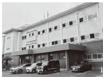
▲戸切小学校校舎棟外壁
