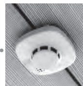
火災警報器の例
