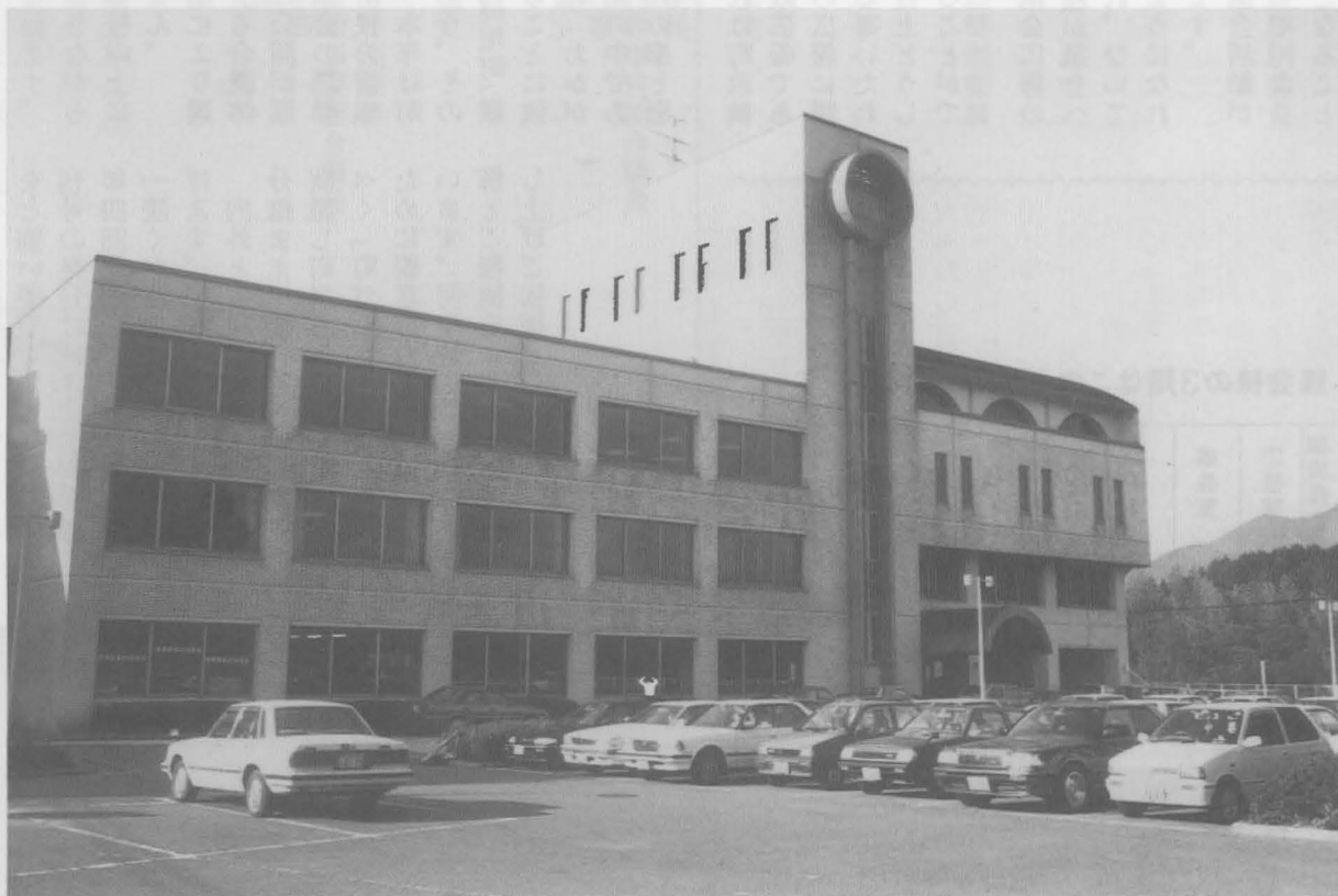
岡垣町議会棟全景
