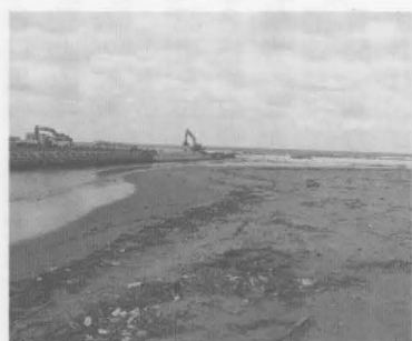
変わってしまった河口と建設中の導流堤
