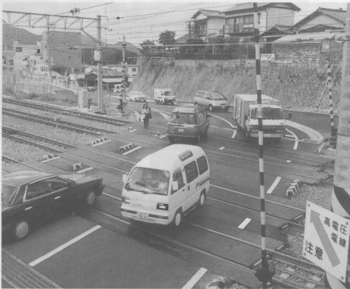
拡幅工事で対面通行が安心してできるようになりました(白谷踏切)
