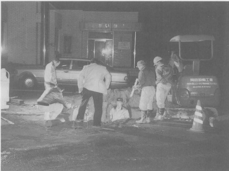
水道管の漏水修理工事をしている指定工事店
