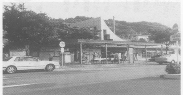
エレベーター設置。住民の願い
