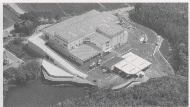
ゴミ中継施設（遠賀・中間リレーセンター）
