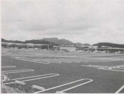
イオン建設中の現場
