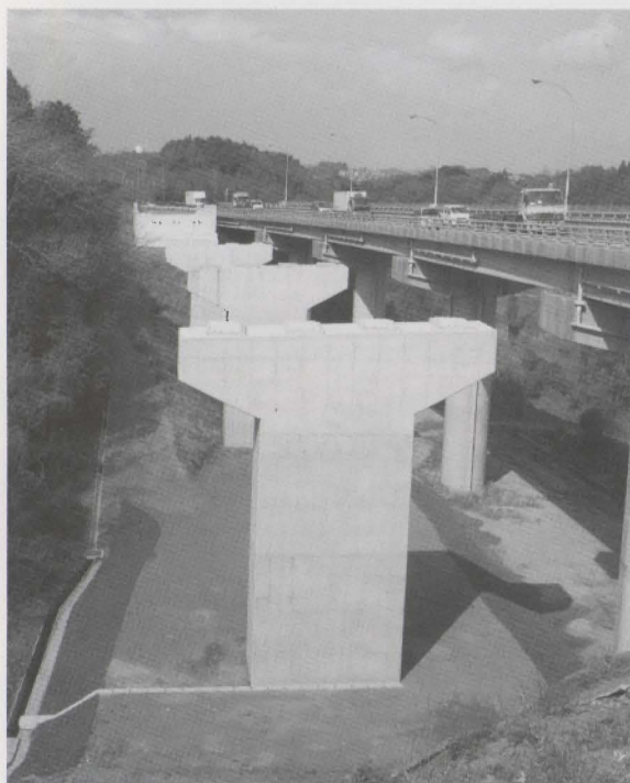
岡垣バイパス工事中
