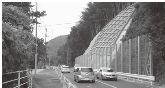
復旧された町道上畑・海老津線
