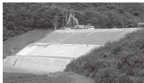
岡垣東中学校のり面工事
