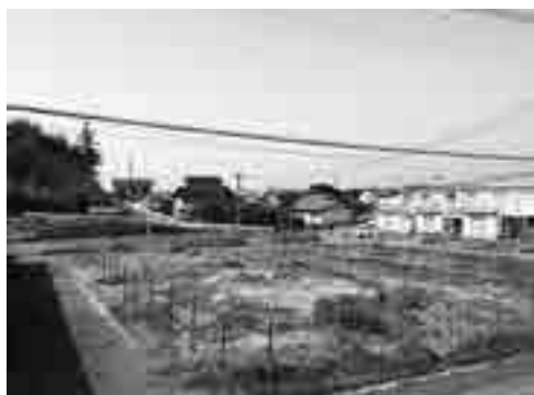
町営住宅建設事業 3754万円
