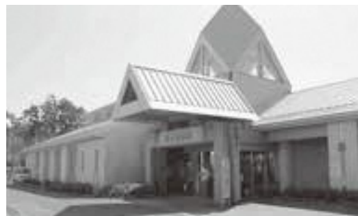
いこいの里空調工事
