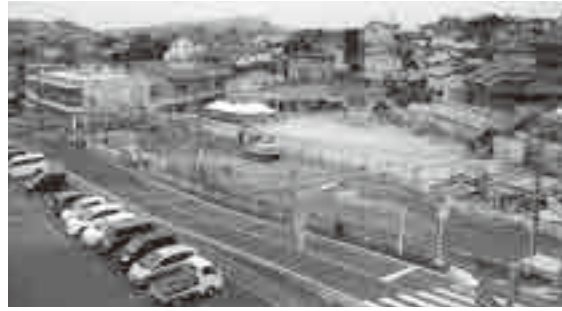
建設中の認定こども園
