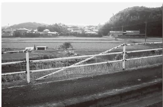
町内のガードパイプが腐食し、寄りかかった高齢者が転落する事故があったため、腐食したガードパイプを点検して修復します。
